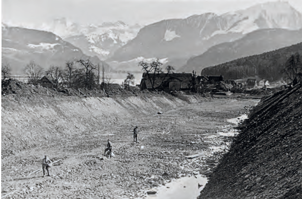
Construction du premier tronçon autoroutier de Suisse, vers 1954. L'ouvrage coûta 7 millions de francs, dont 60 % furent alors pris en charge par la Confédération.
