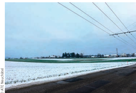
Le futur pôle de développement économique «Littoral Est» est prévu sur ce terrain, avec une ligne de transports publics à prolonger.
