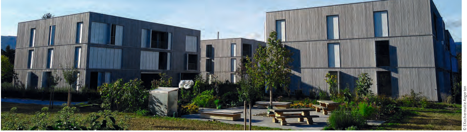
Dans le lotissement Kochermatte à Aegerten (BE), des appartements sont réservés aux personnes ayant des besoins particuliers.
