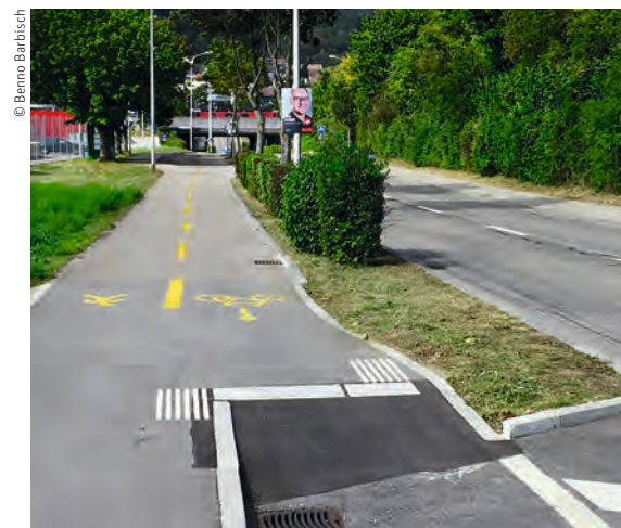
Biberist (SO): Une rampe que l'on peut parcourir à vélo. En même temps, les personnes malvoyantes peuvent s'orienter grâce aux bandes blanches (lire l'article en page 27).
