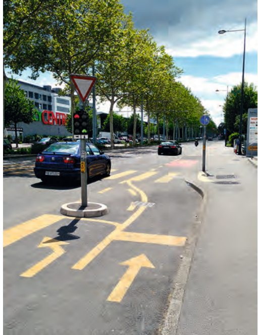
Virage à gauche sûr pour les vélos grâce aux feux de circulation à Petit-Lancy (GE).
