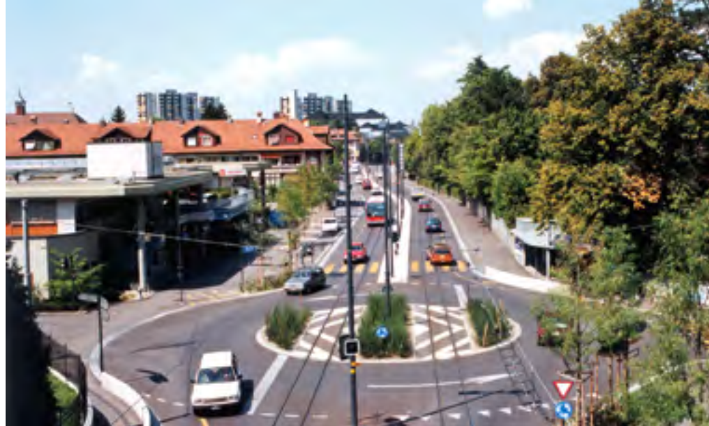
La Seftigenstrasse avant et après son réaménagement en 1997
