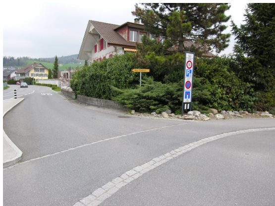
Abbildung 3: Torelement «Stele und Trottoirüberfahrt»
