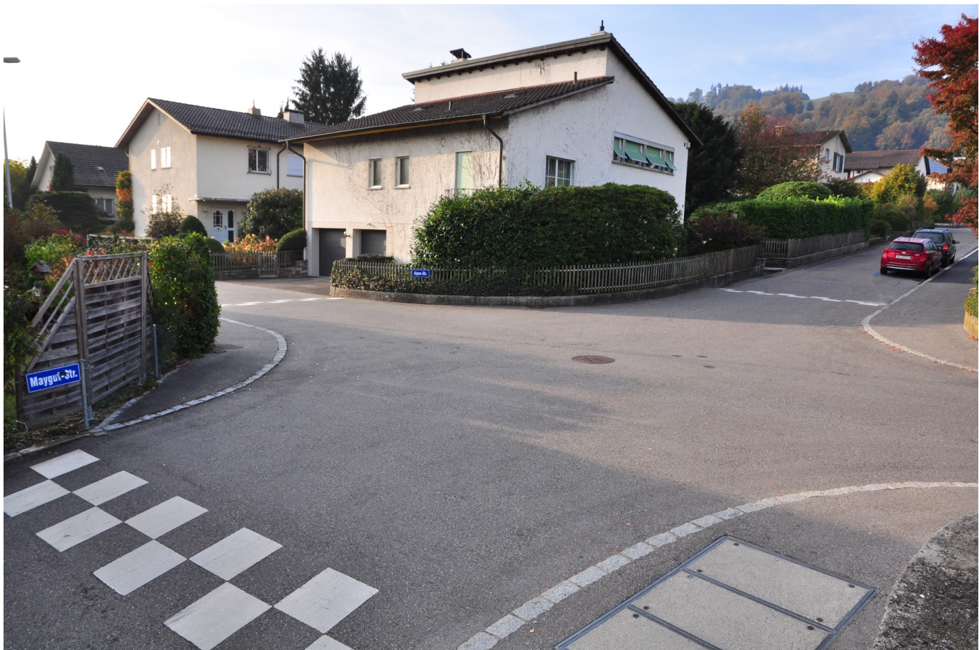
Abbildung 10: Vertikalversatz als Aufpflasterung einer ganzen Kreuzung
