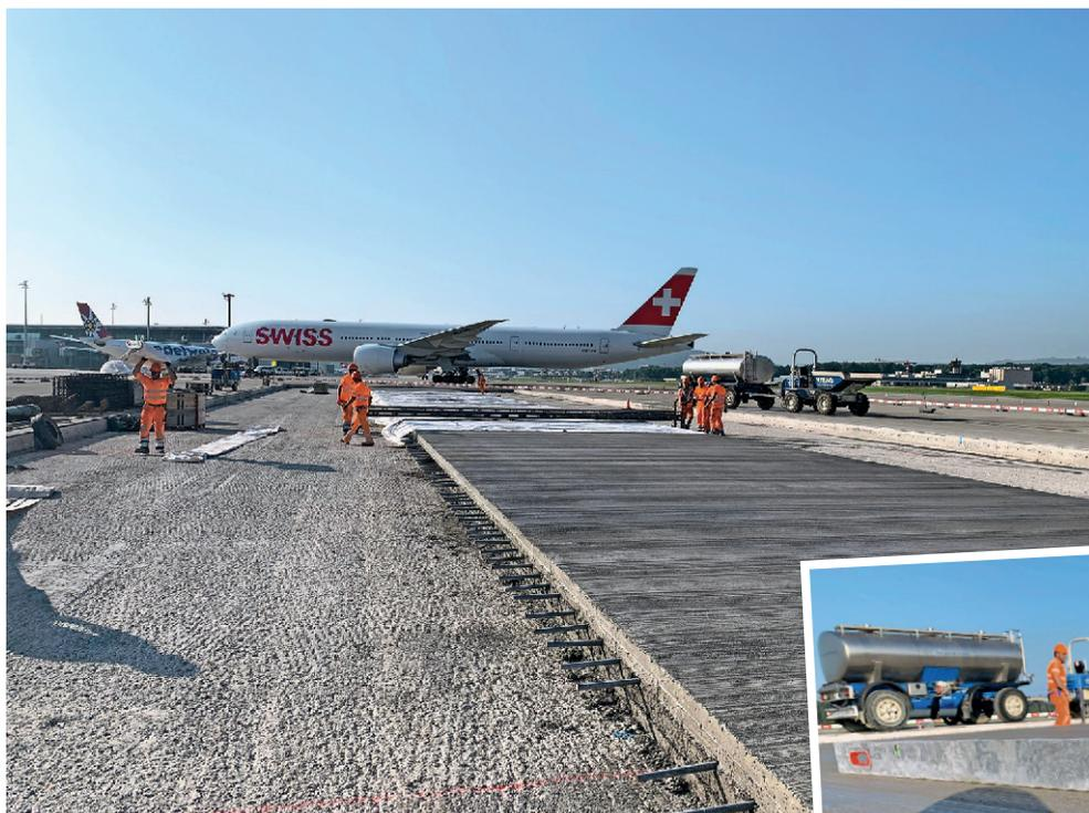
8 | Nachbehandlung der eingebauten Stehbahn (Curing und anschliessendes Abdecken mittels Vliesmatten).
