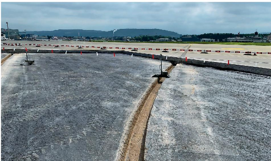
7 | Graben für die Verlegung der Rolllinienbefeuerung.
