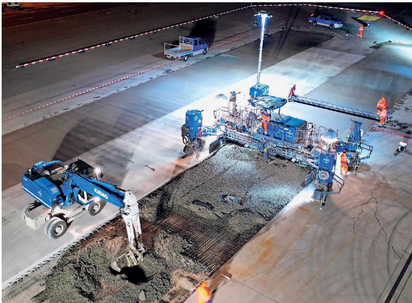
1 | Der bestehende Betonbelag des Rollwegs Foxtrot am Flughafen Zürich wird durch einen neuwertigen Betonbelag ausgetauscht.
